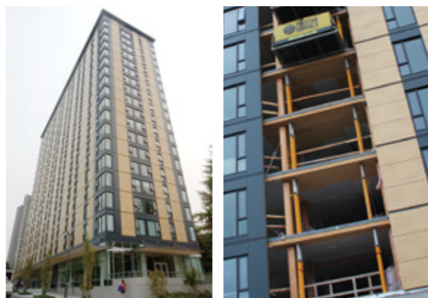
カナダのプリティッシュ・コロンビア大学の学生寮（右は建設中の写真） （写真提供：（左）日本CLT協会、（右）福島孝志/日建設計）
